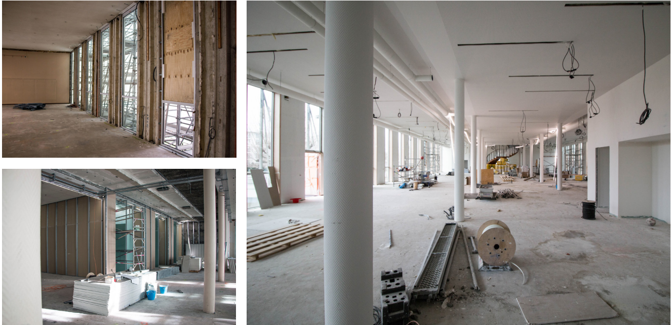
Chantier du CRCN
